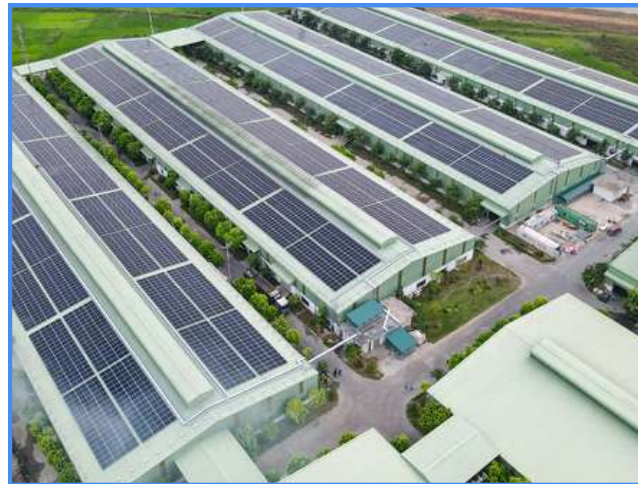
DỰ ÁN ĐẠI DƯƠNG THANH HÓA CÔNG SUẤT: 4,1 MWP
