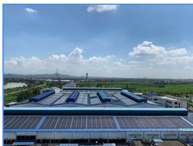
DỰ ÁN PACIFIC, HẢI DƯƠNG CÔNG SUẤT: 2,5 MWP
