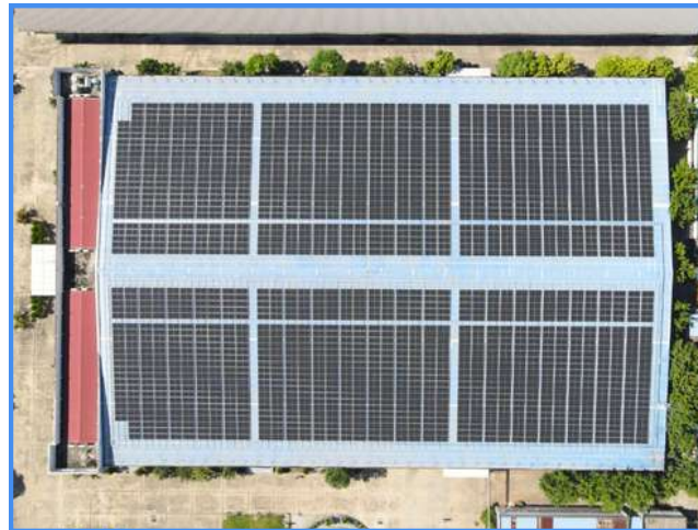
DỰ ÁN MÁY 10 THIÊU ĐÔ, THANH HÓA CÔNG SUẤT: 1 MWP
