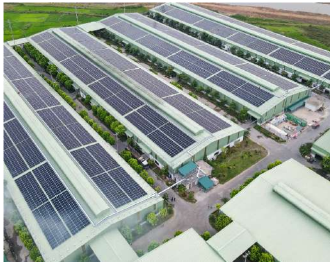
DỰ ÁN ĐẠI DƯƠNG THANH HÓA CÔNG SUẤT: 4,1 MWP
