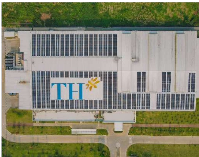
DỰ ÁN TH TRỤY MILK NGHỆ AN CÔNG SUẤT: 5,3 MWP
