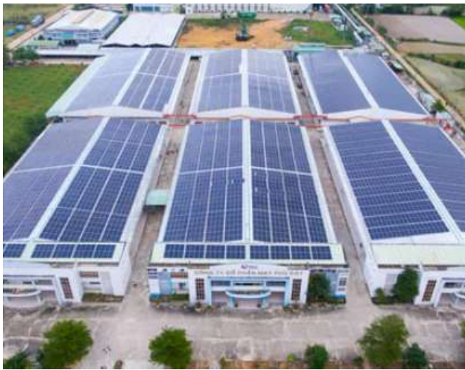
DỰ ÁN MÂY PHÙ CÁT, BÌNH ĐỊNH CÔNG SUẤT: 1 MWP
