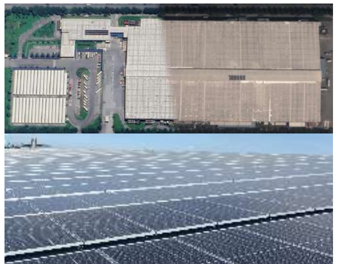
DỰ ÁN FUSAN, BẮC NINH CÔNG SUẤT: 6,2 MWP
